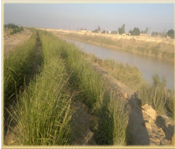
تثبیت کناره ها و مهار سیلابهای فصلی کار مشترک با شهرداری هندیجان
